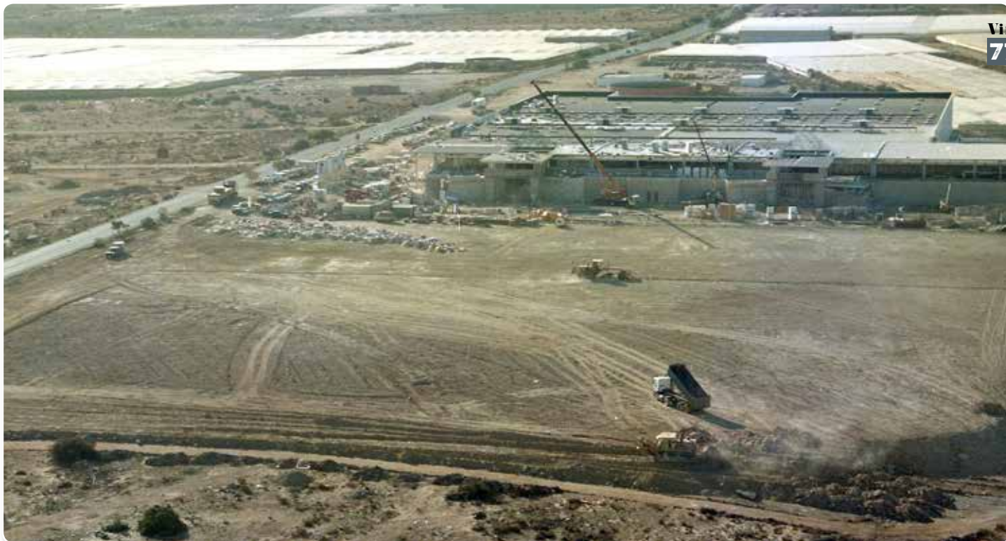
Año 1995. El Centro Comercial Copo en sus primeras fases de construcción.
