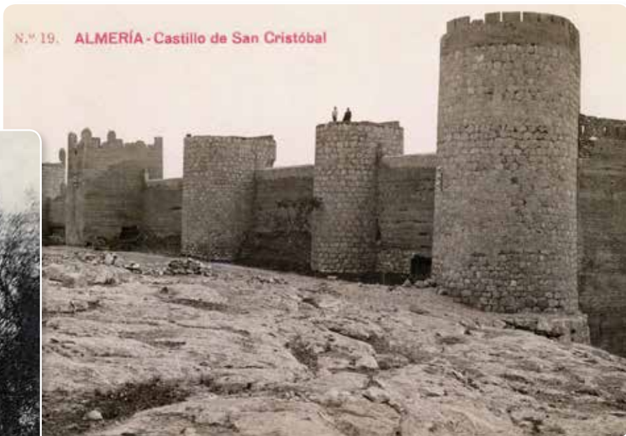
Esta vista parcial del Castillo de San Cristóbal, en progresivo deterioro, data de 1913 y pertenece a la serie Geografía del Reino de Andalucía. Ubicada estratégicamente, esta edificación militar se alza sobre el cerro frente a La Alcazaba de Almería, siendo accesible a los visitantes que a principios del siglo XX aún podían subir a sus torreones. Col. Narciso Espinar Campra.
