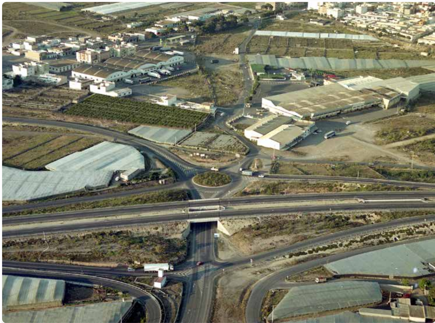
Salida de Ejido Oeste por el Camino de Adra en 1997. Las grandes naves de las alhóndigas Agroejido y Femago destacan en el paisaje, aún dominado por invernaderos y solares sin edificar.
