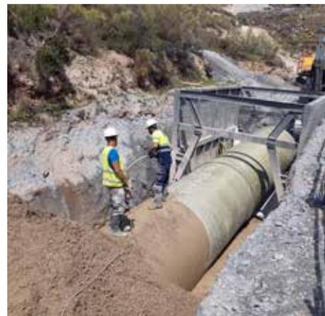
Sustitución de canal por tubería en el canal de Benimar.
