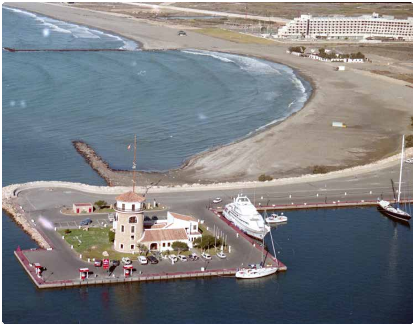
Año 1995. Almerimar creciendo imparable. La torre del puerto en primer plano. Al fondo, el hotel Almerimar y el Club de Playa ven cómo las urbanizaciones van creciendo a su alrededor.
