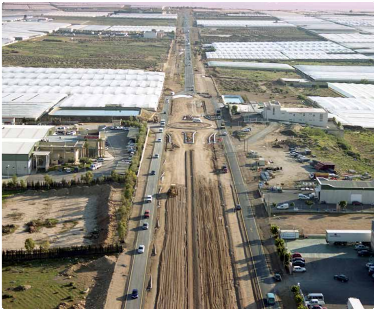
Panorámica de la remodelación de la carretera de Almerimar.
