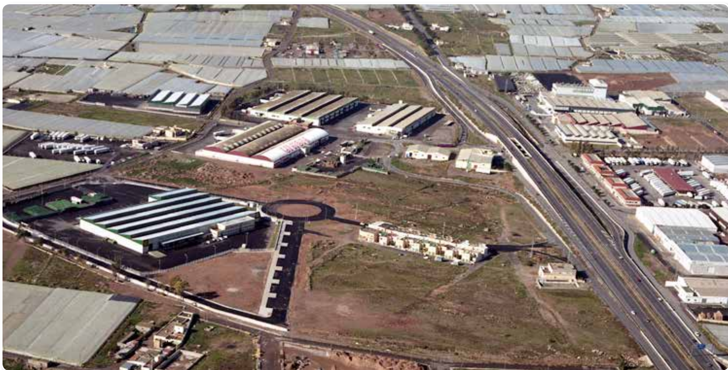
Lado sur del Polígono Industrial La Redonda, destacan las naves de Mercopal, La Unión, Agrupaejido y Femago.
