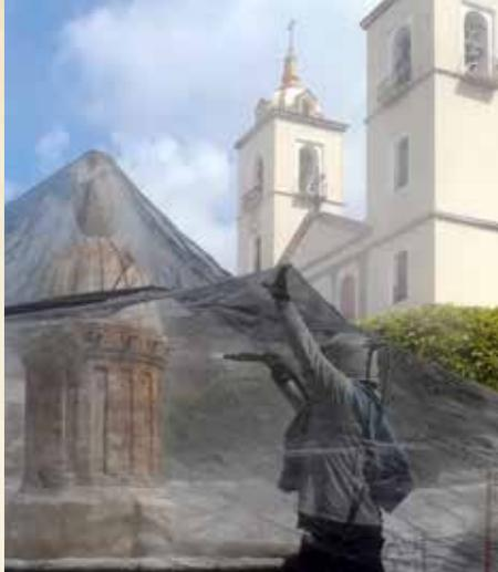
*Proceso de limpieza de la fuente mediante chorro de arena.*
