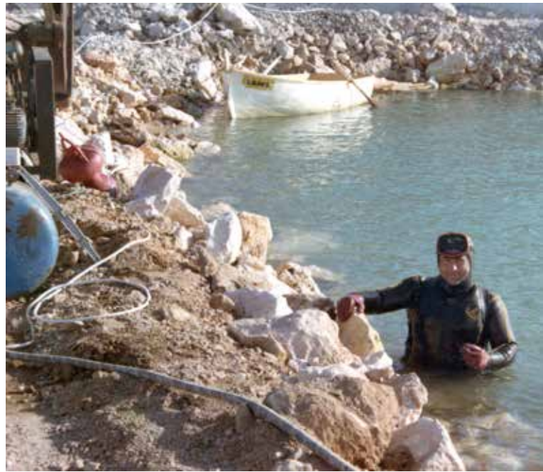
Paco Llorente y José Rodríguez realizando trabajos en la escuela de vela del puerto de Almerimar, en 1975.
