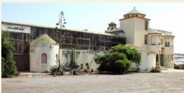
Estado que presenta actualmente la fachada de la discoteca.
