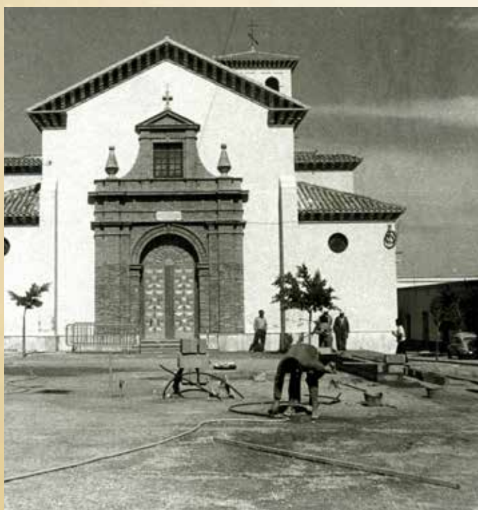
Obras de remodelación de la plaza en el 87.
