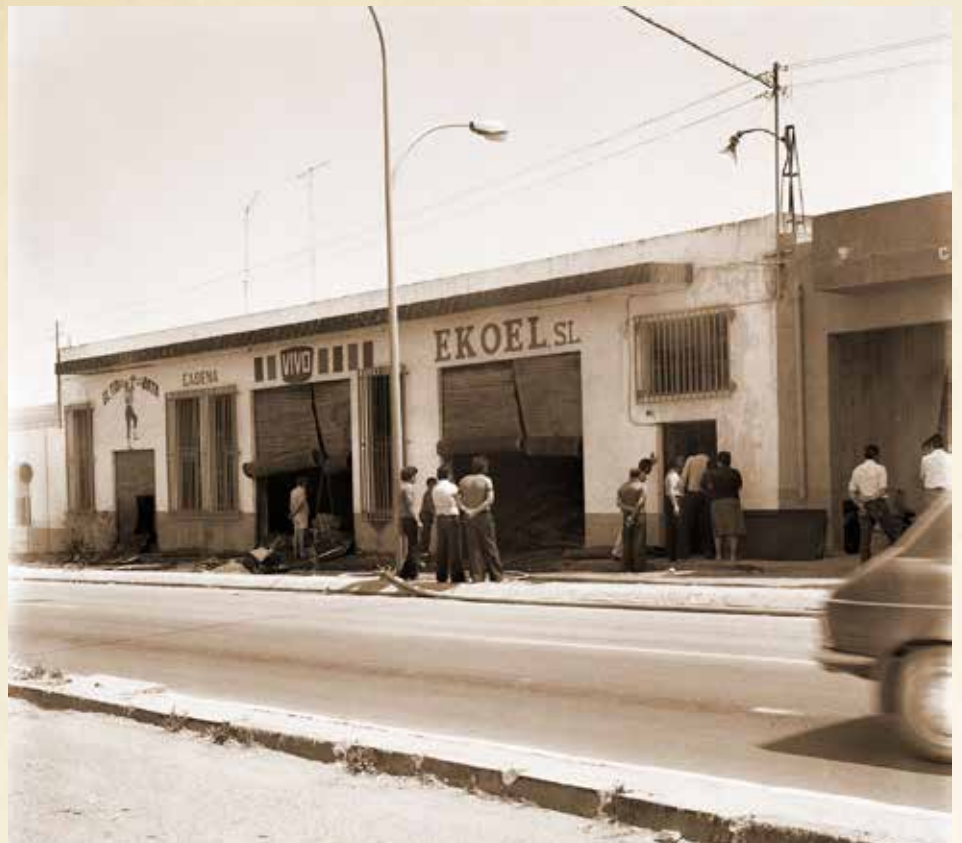
En 1979 el almacén del Ekoel sufre un incendio. El primero en llegar fue Jorge Cantón con sus cubas. Las mangueras se dejaban tiradas en el suelo cuando las cubas iban a recargarse de agua.
