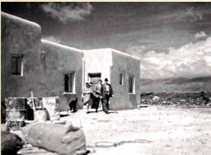
Inicio de la construcción de viviendas.
