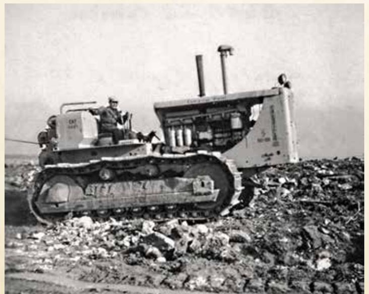
Equipo de roturación: 'riper' arrastrado por un oruga de cadenas "Caterpillar"
