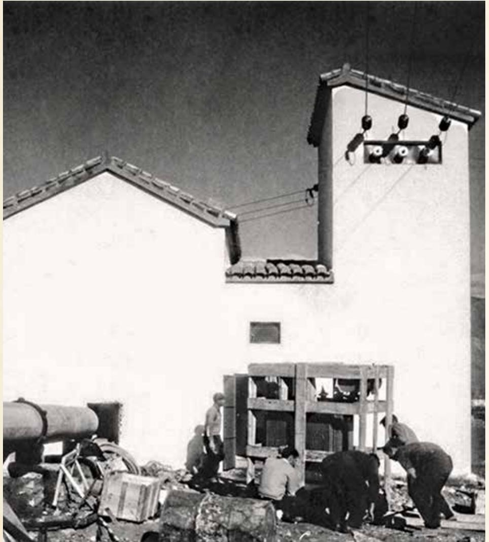
*Construcción de un centro de transformación y equipo para un pozo.*
