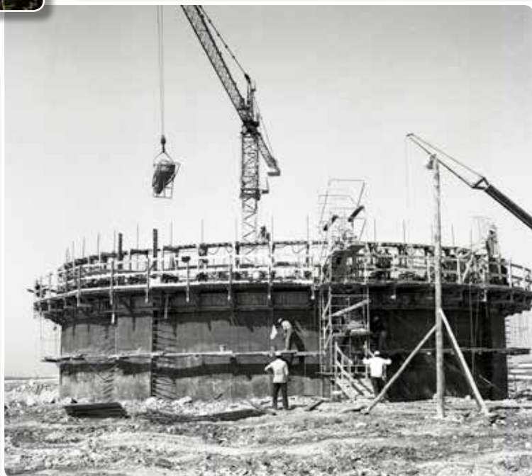
1977. Construcción del depósito de agua de Almería
