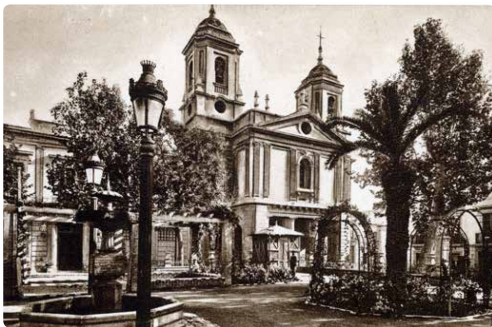
Fachada de la iglesia de San Pedro con una vista general de la plaza.
