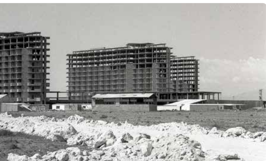
Construcción de las torres de Almerimar en 1974.
