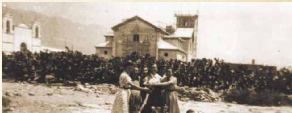
Imagen de la ermita y la iglesia en construcción en 1953.
