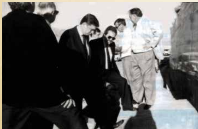
Recorrido por las obras de mejora de regadío del Poniente. Foto: La Gaceta.
